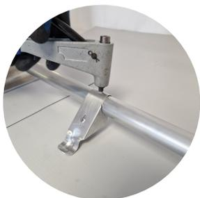
Die Eiskralen werden gerade geliefert, bei der Montage muss man lediglich die Eiskralle um das Rohr biegen und mit Nieten befestigen.
