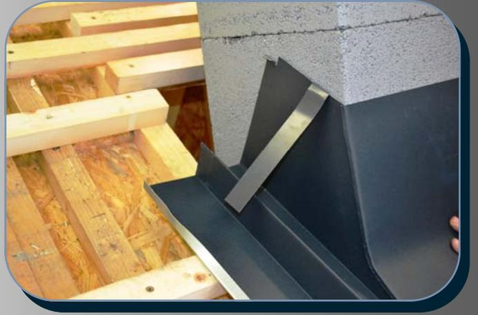
Fixieren des Brust- und Schluchtenbleches mittels Einhängehafter auf die Dachlatten.
