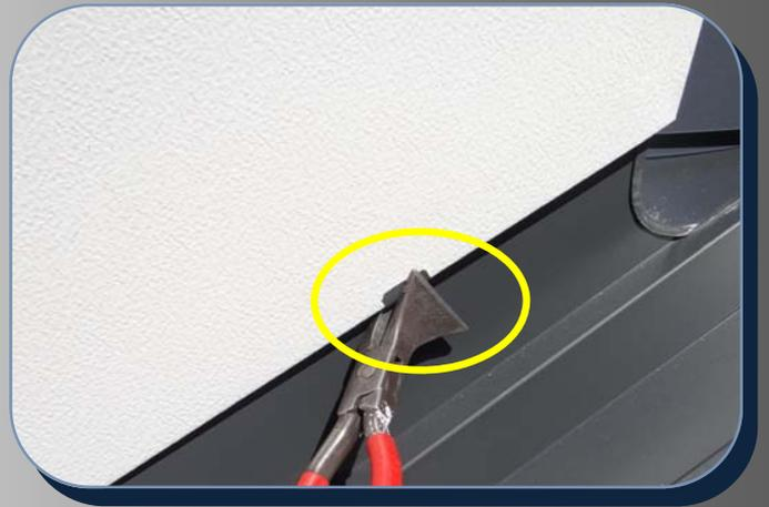
Dachziegel müssen min. 8 cm das Schluchtenblech überdecken.
