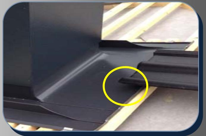
Schutzfolie an der Unterseite des Klebmetalls entfernen und an die Dachziegel andrücken.
